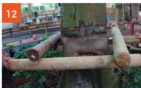
Instalación de los troncos de la plataforma
