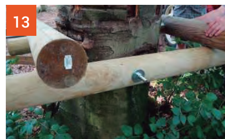
Fijación con tuercas y arandelas
