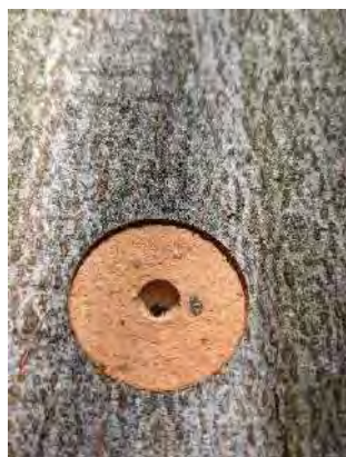
2.6.1 Crear una superficie plana con una broca de mariposa de Ø 40 mm
