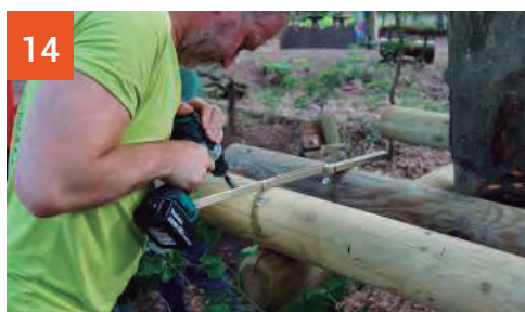
Fijar el resto de elementos del chasis de la plataforma
