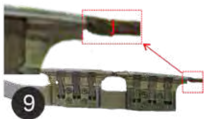
9 Vérification des déplacements des câbles en début et en fin des doubles bras destinés aux tyroliennes
