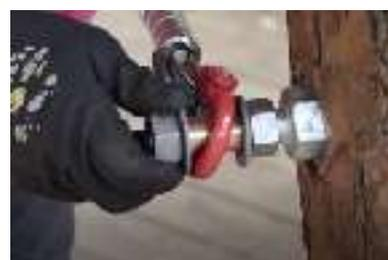
**Note 4:** lorsque l'arbre Support a un diamètre important et que la boucle de ligne de vie est positionné à l'opposé de la ligne de vie, il peut être nécessaire d'installer une "Chaine de connecteurs" afin de faciliter le passage des fractionnements sur la ligne de vie améliorer l'ergonomie de l'installation (voir photo + figure 4 ci-dessous.)
