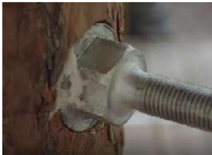
9. **Vissage du clou:** Commencer à visser le clou à la main (vérifier une dernière fois l'orientation du clou). Une fois positionné, visser le clou à l'aide de la douille de 41 en plaçant sur l'écrou juxtaposé à l'épaulement.
