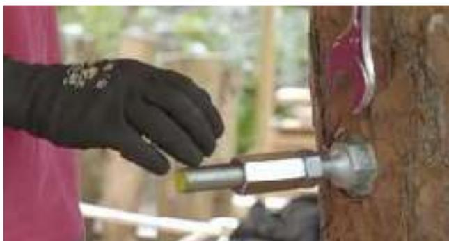
**NOTE 3 :** Un marquage entre l'écrou et le manchon de raccordement permet de valider facilement le maintien du serrage.
