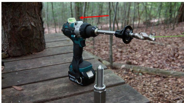
Un trou en plusieurs étapes est maintenant percé conformément aux instructions d'installation des BABO BOLT à l'aide d'un tournevis électrique avec un niveau à bulle ou d'un dispositif de perçage.
